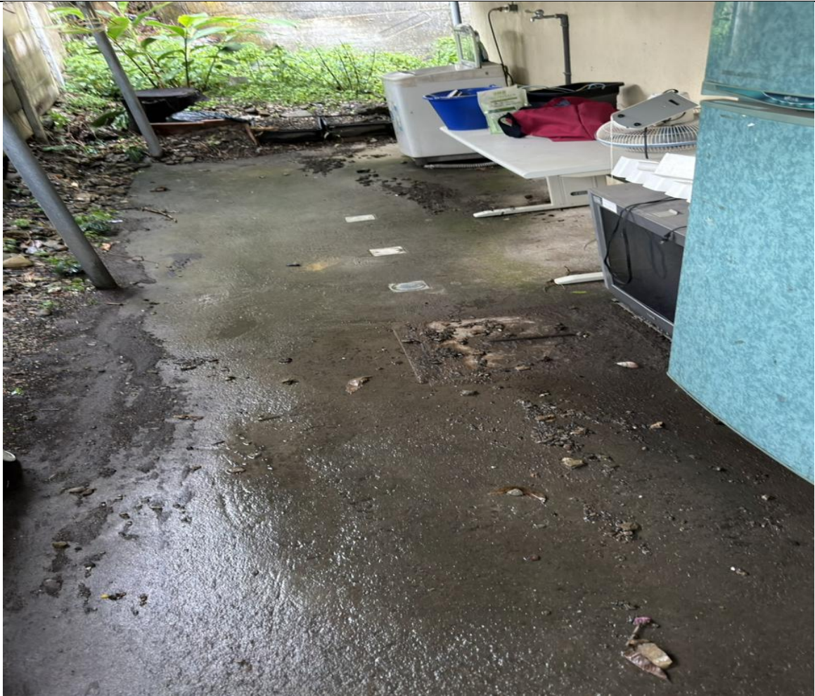
茂林衛生所宿舍後排興設排水溝案
