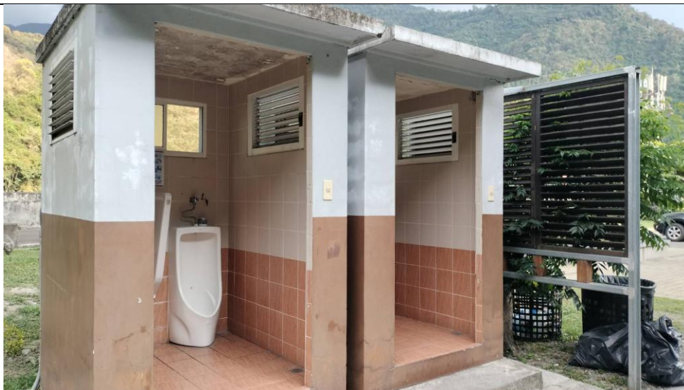
大門公廁修繕分男女廁及搭屋頂美化施改善案
