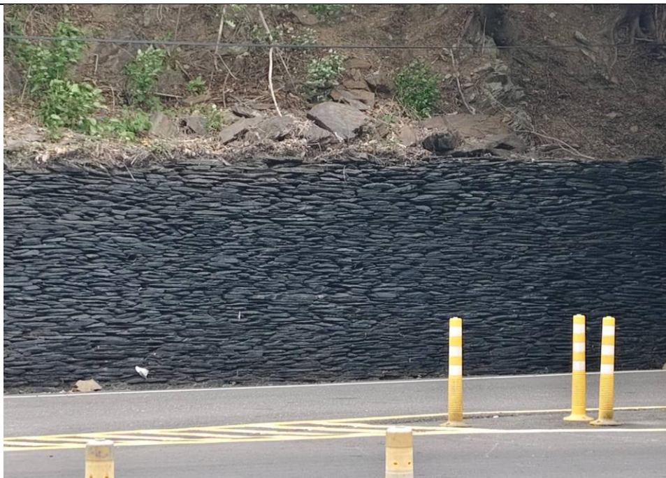
大門邊坡設置防落石網案
