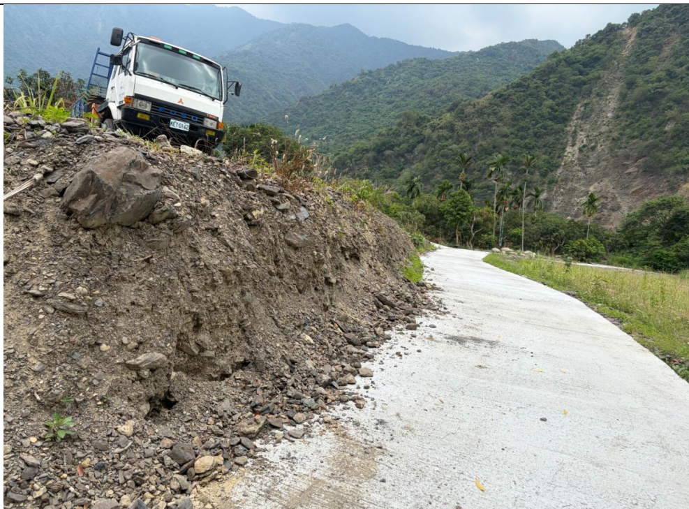
施作茂林一水田擋土牆防止土石滑落案
