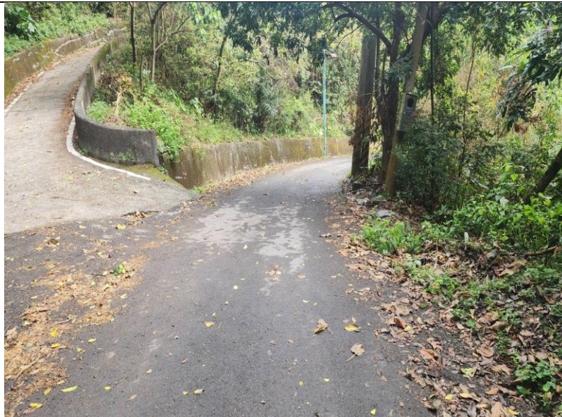
興設多納溫泉聯絡道路側邊導水擋土設施
