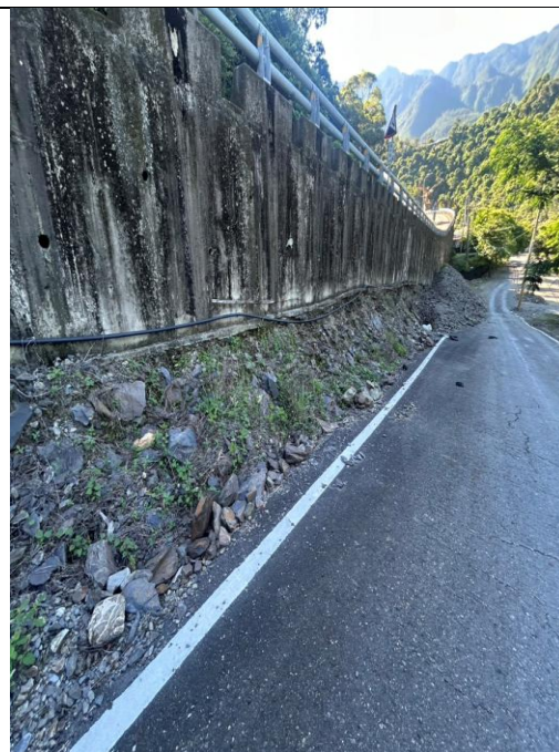
高 132 線多納大橋引道路基已裸露掏空案
