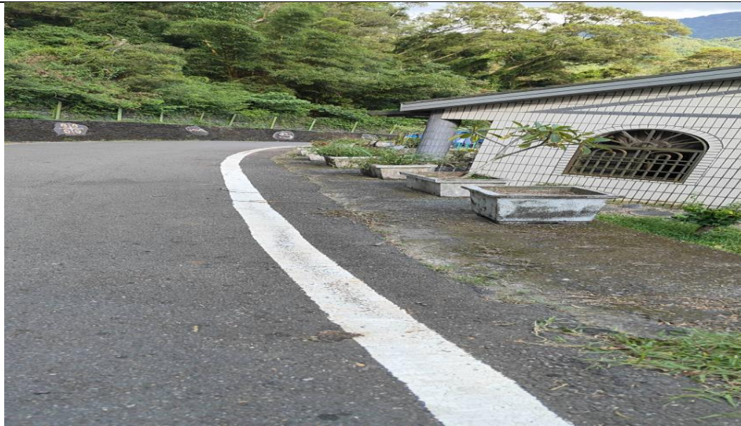
規劃茂林里外環道路綠美化及設置護欄工程案
