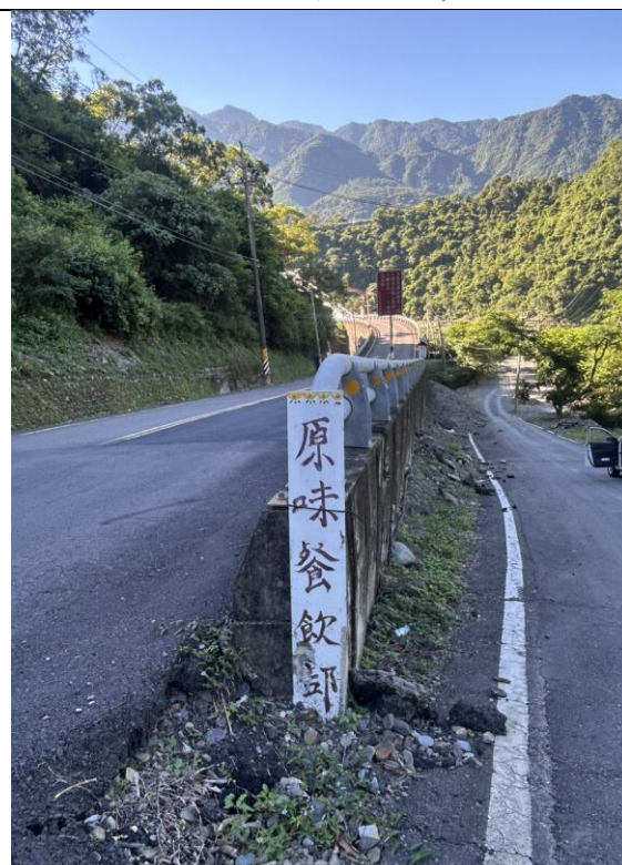
高 132 線多納大橋引道路基已裸露掏空案
