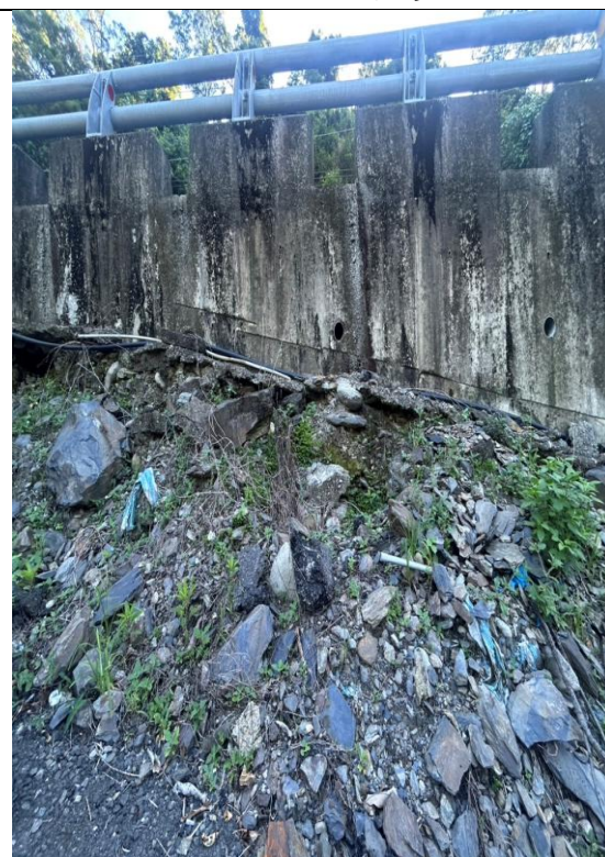
高 132 線多納大橋引道路基已裸露掏空案
