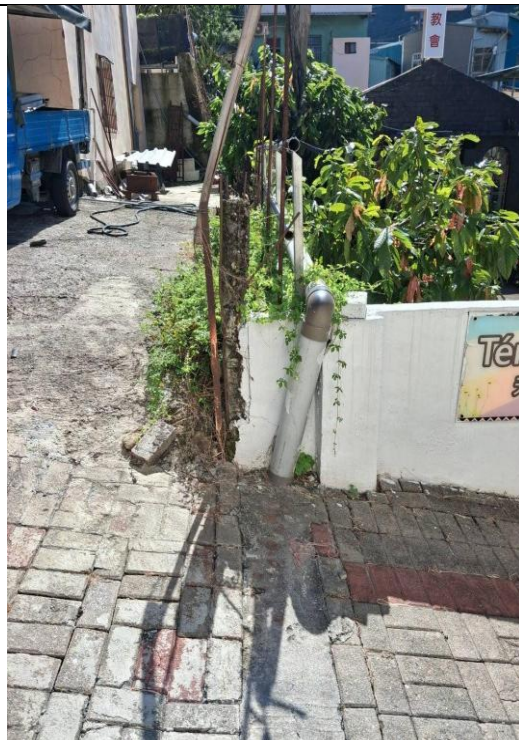
茂林里無設置排水溝及截水溝排水系統第六鄰巷道
