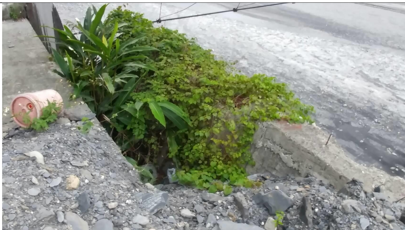
情人谷吊橋修復路面鋪設水泥及興設欄杆案
