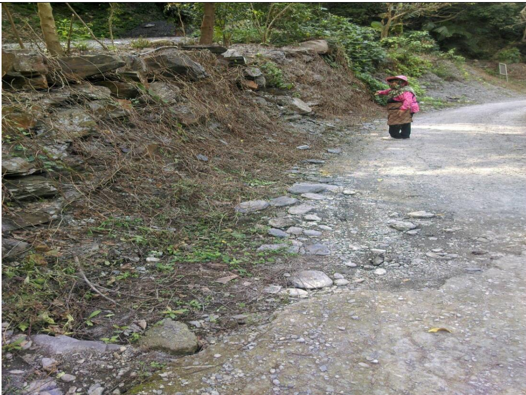
木勝溪步道鋪設水泥及興設擋土牆
