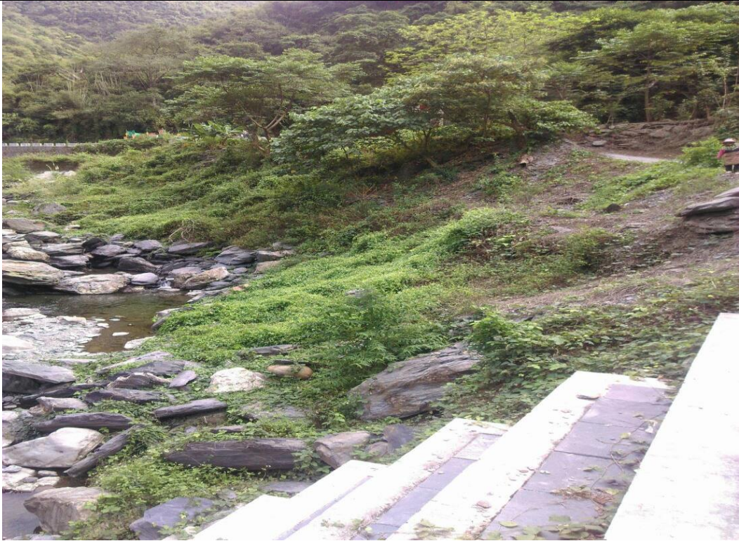
木勝溪步道鋪設水泥及興設擋土牆
